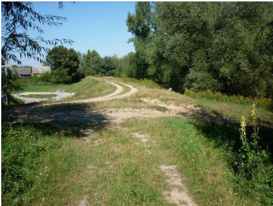
Fot. 3 Wjazd na drogę po koronie wału w km 4+265
