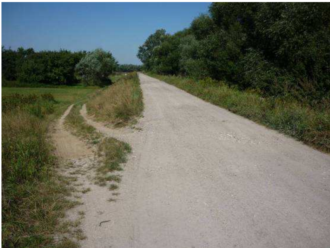
Fot. 1 Umocniona tłuczniem droga na koronie wału w km 2+485 ÷ 3+070
