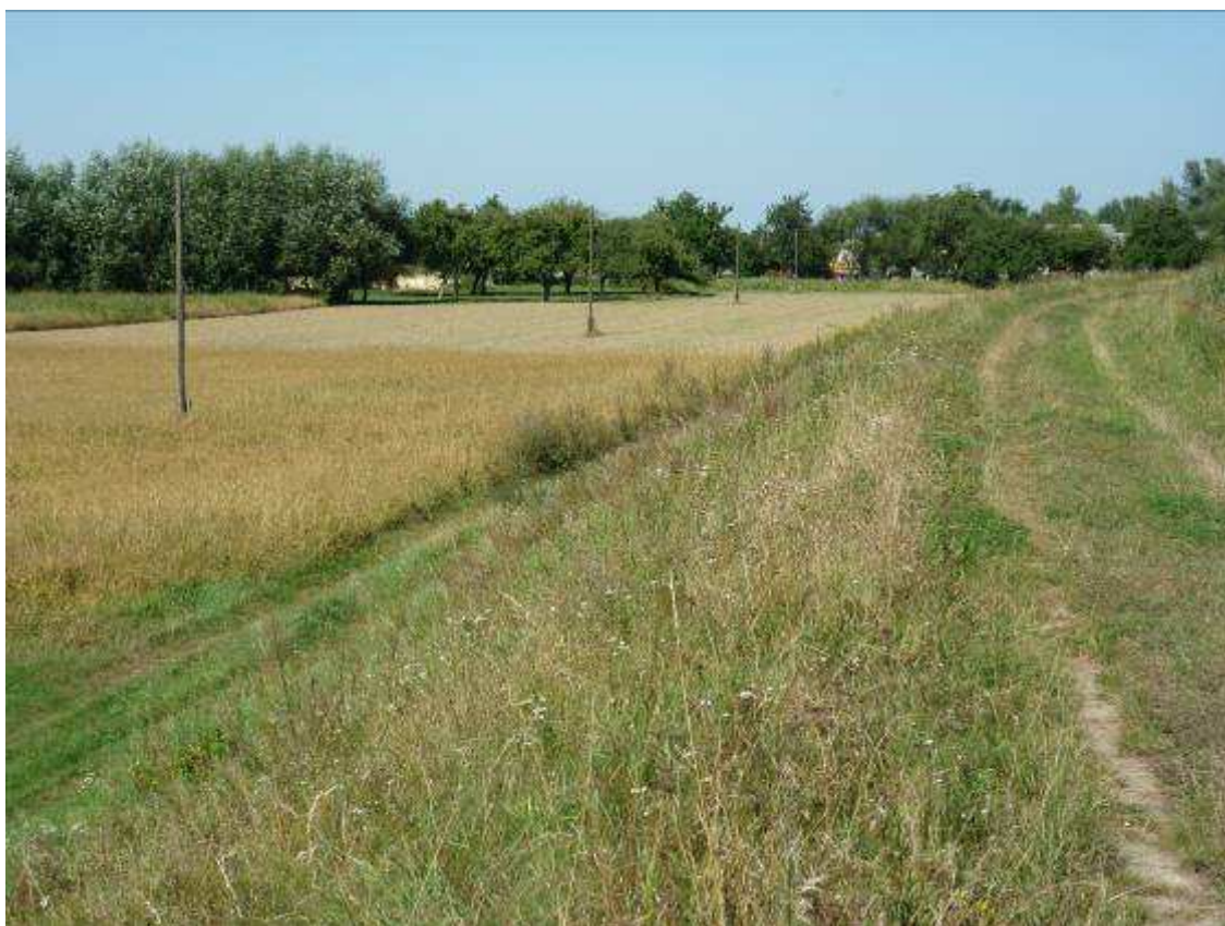
Fot. 2 Droga na koronie wału w km 3+070 ÷ 3+450.
