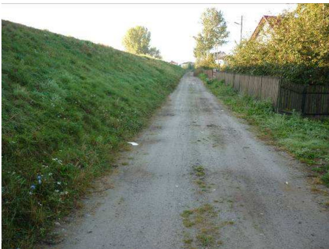
Fot. 13 Dobrze zadarniona skarpa z drogą przywałową umocnioną tłuczniem na terenie woj. mazowieckiego.
