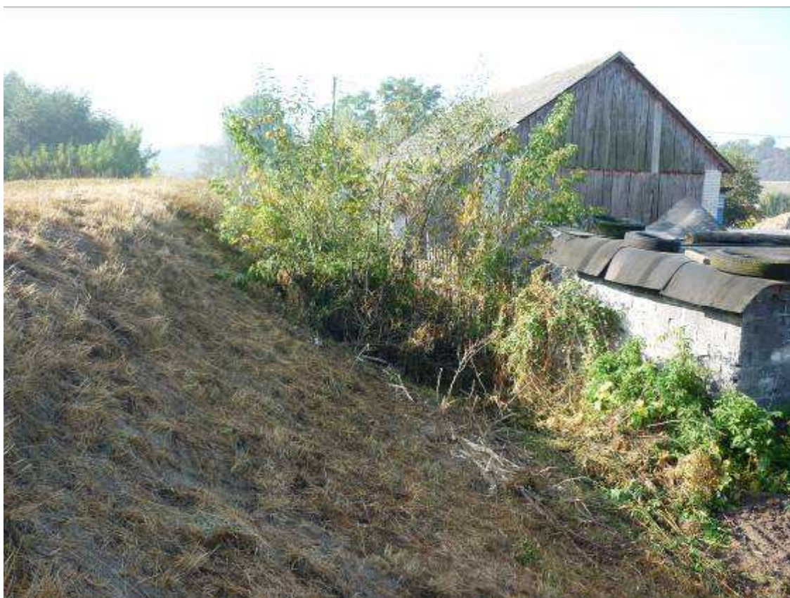
Fot. 9 Niewykoszona odpowietrzna skarpa wału z wkraczającą roślinnością drzewiastą
