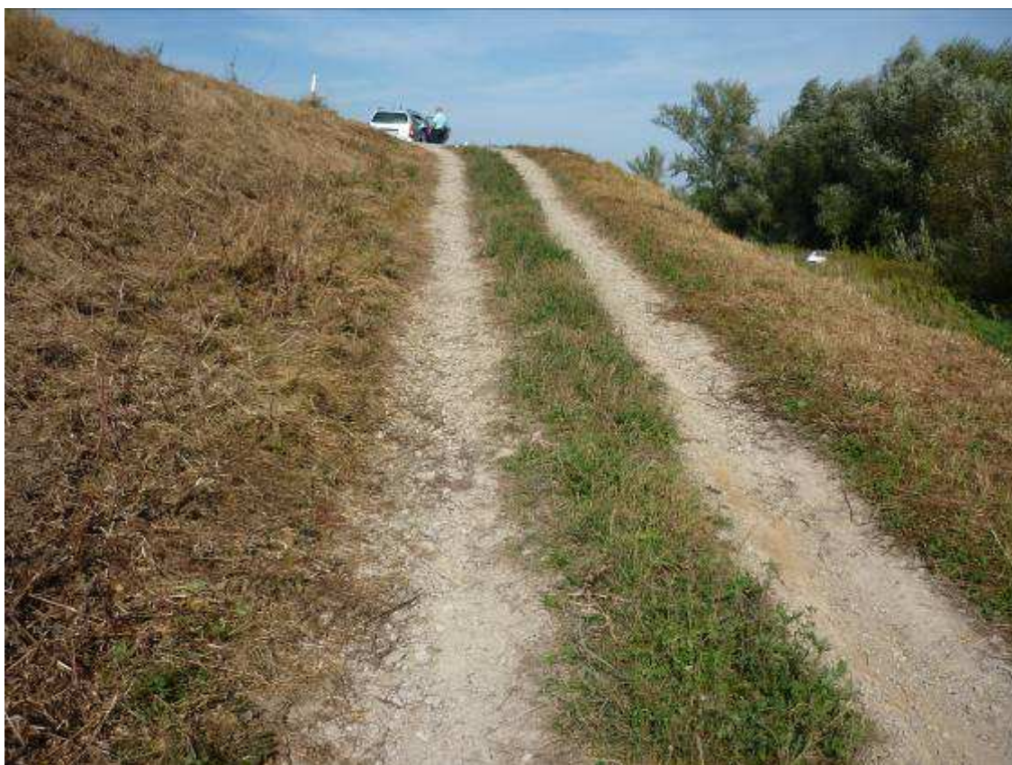
Fot. 5 Umocniony tłuczniem podjazd na koronę wału od strony odwodnej w km 5+023
