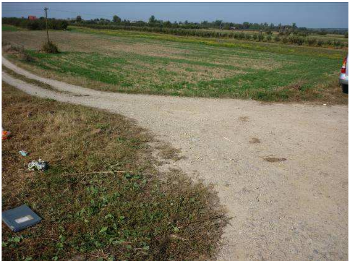
Fot. 31 Utwardzony tłuczniem podjazd na koronę wału w km 5+023.
