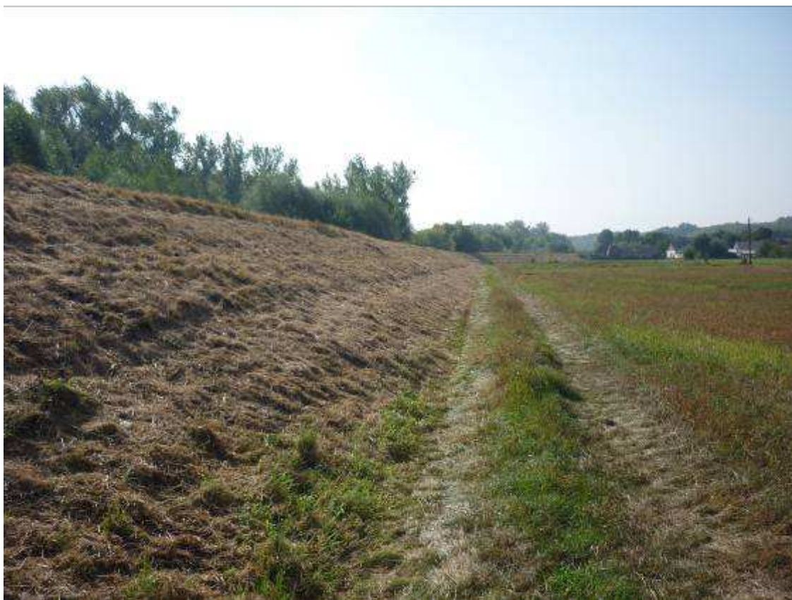
Fot. 33 Ślad drogi przy skarpie odpowietrznej
