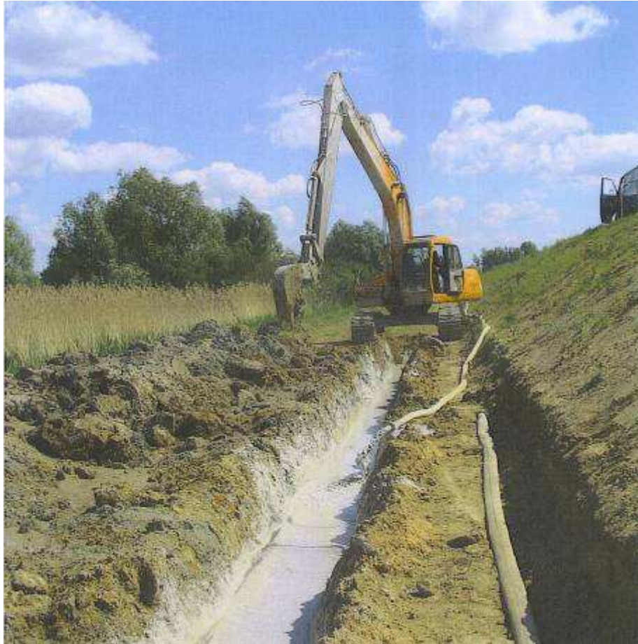
Fot. 35 Wykop wąskoprzestrzenny koparką i wypełnienie szczeliny zawiesiną
