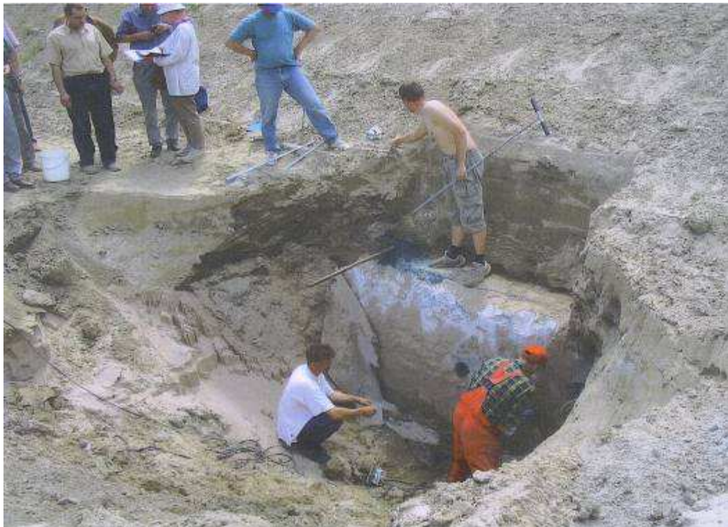
Fot. 36 Odkopana stwardniała przesłona bentonitowo - cementowa
